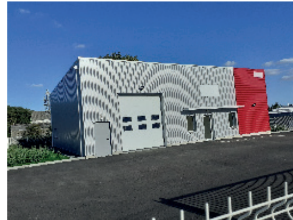
Composée de 5 ateliers & 5 bureaux
