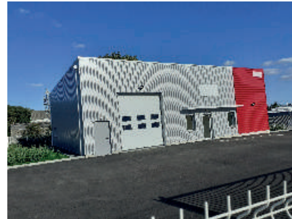
Composée de 5 ateliers & 5 bureaux
