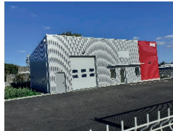
Composée de 5 ateliers & 5 bureaux
